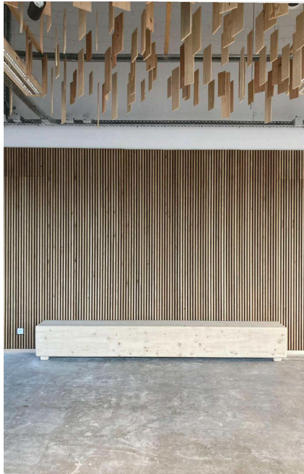
▲ Réalisations de bancs en bois massif dans l'ERP à partir des poutres de réemploi ci-contre (03/01/24)
