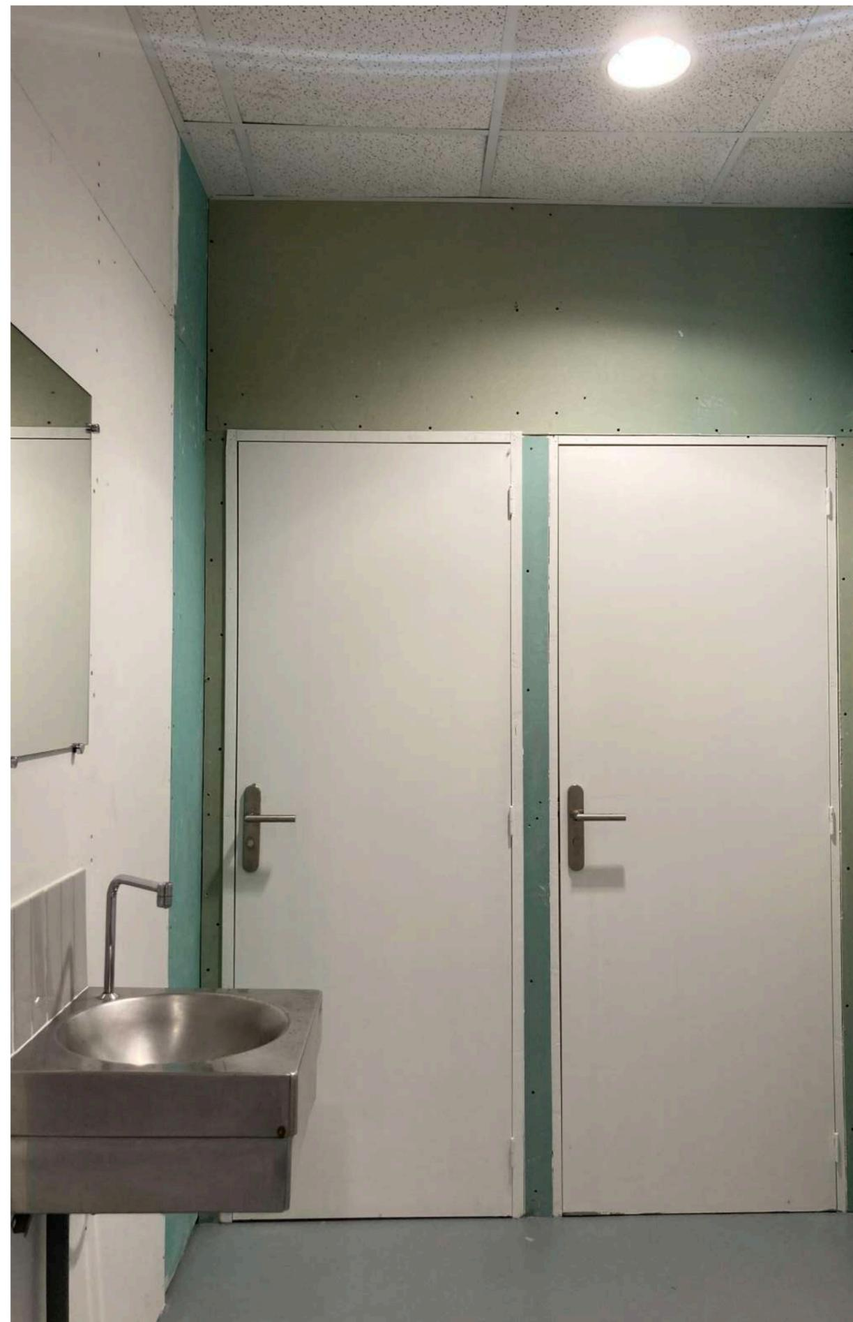
▲ Mise en œuvre des plaques de plâtre de réemploi, portes lave-main, faïence et miroir de réemploi (28/02/24)
