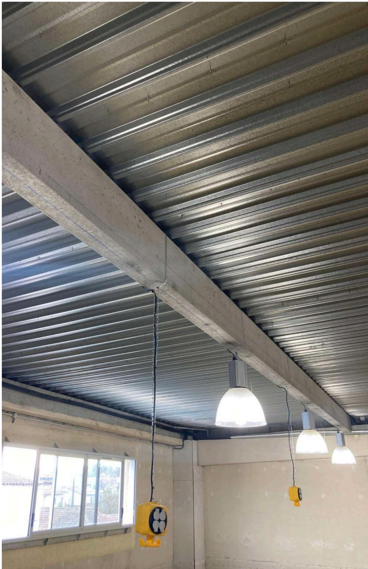
▲ Luminaires industriels de réemploi posés après remplacement des ampoules pour une technologie LED (17/05/23)
