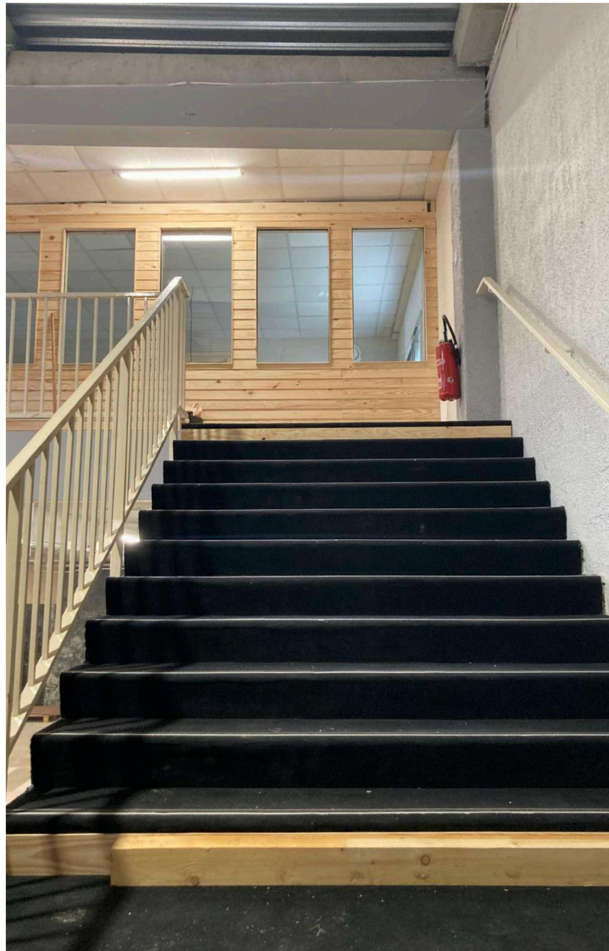
▲ Pose des contre-marches d'escalier en bois de réemploi et cloison vitrée de réemploi à l'étage (28/02/24)
