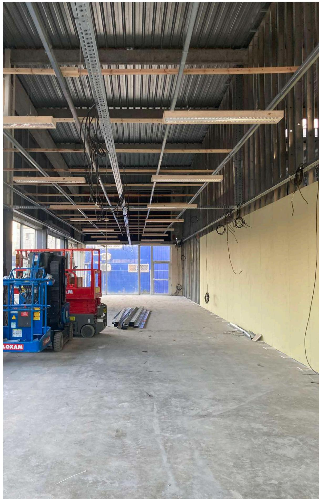
▲ Pose des rails lumineux de réemploi reconditionnés (23/10/11)
